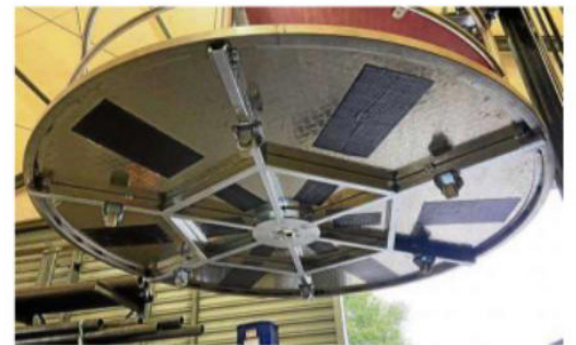
Alle sichtbaren Metallteile sind aus Edelstahl, die Böden aus Aluriffelblech und die Sitzflächen aus Polyethylen.
